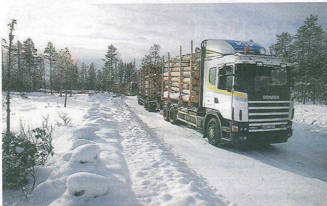
För att körbanan inte ska välta upp och ned när de tunga timmerbilarna passerar har man trampat snön med bandvagn för att få myren att frysa flera meter ut från själva vägen.
